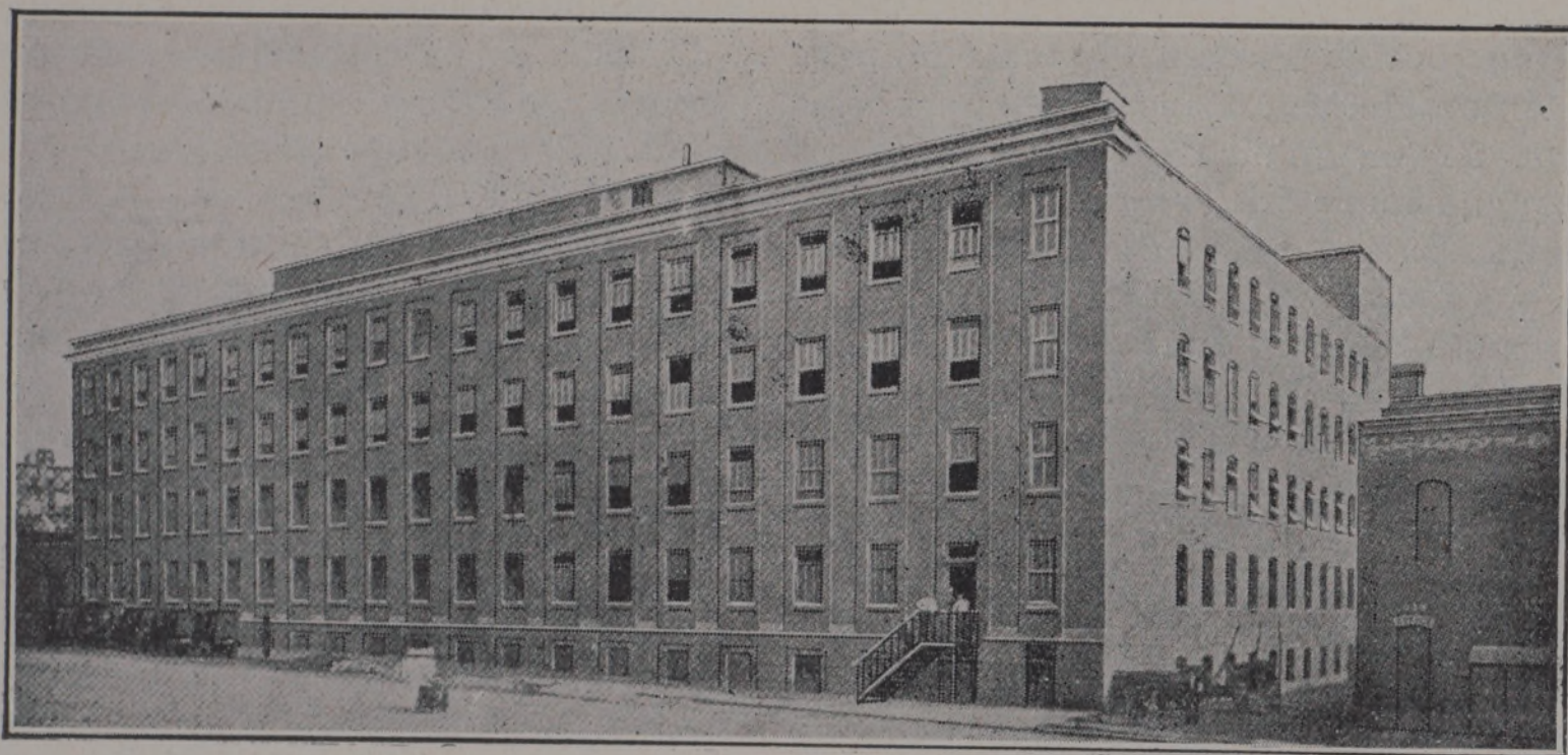
Fig. I. — Vue d'ensemble du garage de la New-York Taxi-Cabs Company. (Voir le plan de la fig. VIII).
